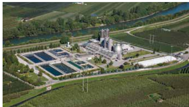
Depuratore di Bronzolo
