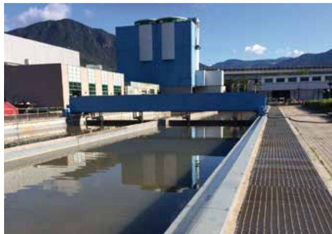
Depuratore di Bolzano
